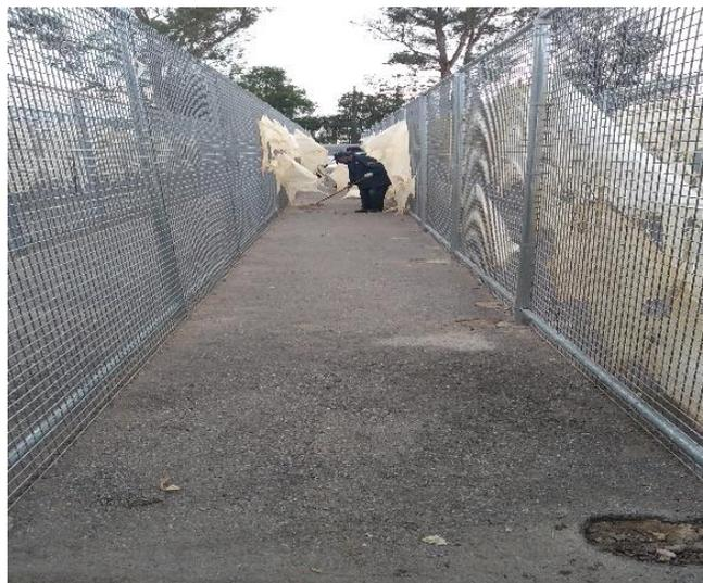
Imagen 16 Remplazo de mallas ciclónicas
